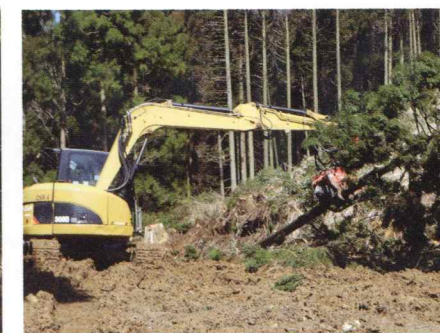
スイングヤーダ(林業機械)を使って伐採した木をおろした後、枝をきれいに払っていきます
