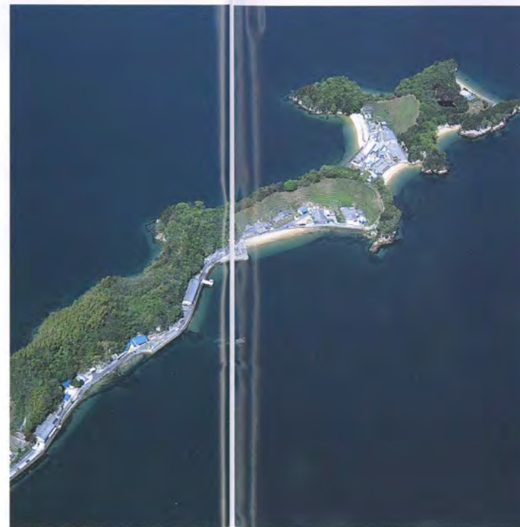
江田島工場 屋形石分工場 Etajima Yakataishi Plant
