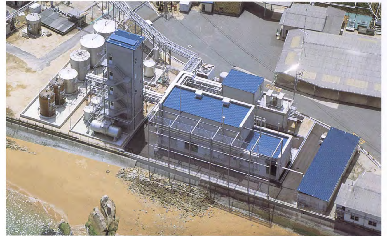
TNTプラント (全景) TNT Plant (Full View)
