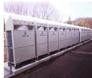
空調設備(ビル用マルチエアコン)
