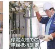
停電点検での絶縁抵抗測定
