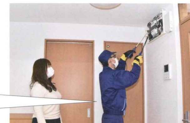
屋内の電気設備の調査
