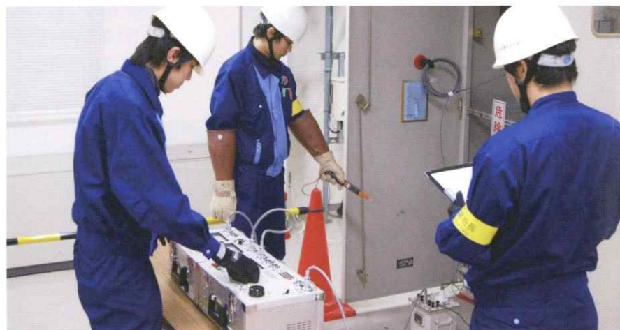
絶縁耐力試験
