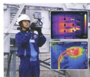
無停電・非接触による過熱診断
