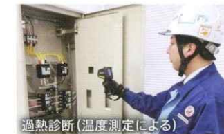
過熱診断(温度測定による)
