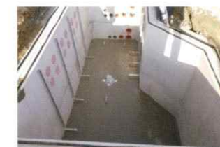
3 下床版 コンクリート 打設
