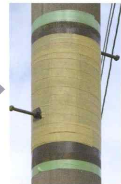
アラミド補修状況
