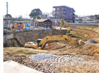
土壌浄化修復工事
