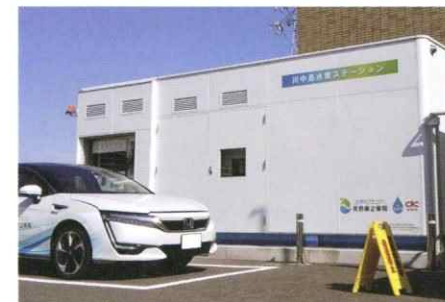
再生可能エネルギーを使ったパッケージ型水素ステーション「SHIPS」
