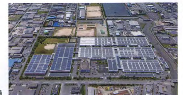
長府製作所 本社工場
