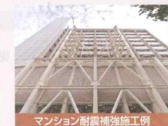
マンション耐震補強施工例
