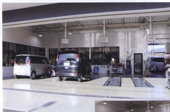
2方向をガラス張りにしたサービスホール
