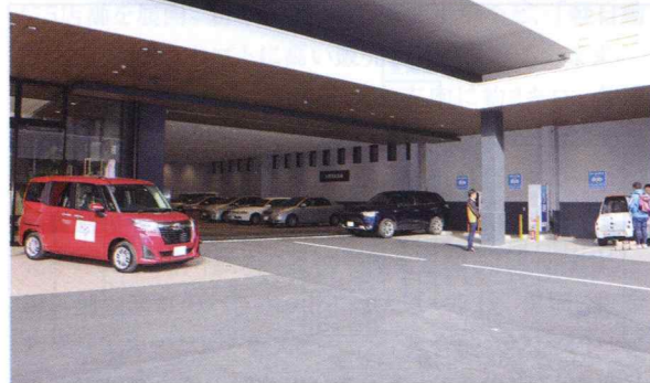
店舗・工場入口。お客様駐車場も雨天時を考慮し屋内に
