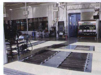
検査ラインにはネットワークシステムを導入
