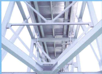
長島大橋（空撮事業）
