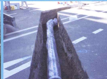
城町（上下水道施設工事）
