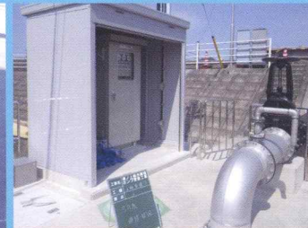
須ノ上排水機機場ポンプ（機械器具設置工事）
