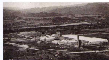
1931年に生産を開始した「ベンベルグ™」工場(宮崎県延岡市)
