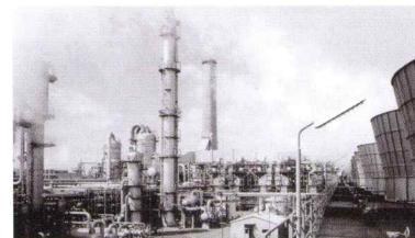
エチレンプラント(岡山県倉敷市)
