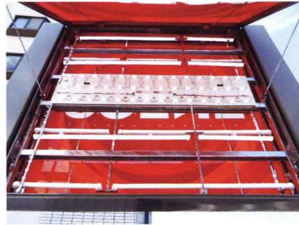
サインのLED化により美しくより効率的に。
