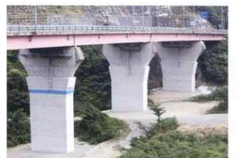
橋梁耐震補強設計(工事完了後)
