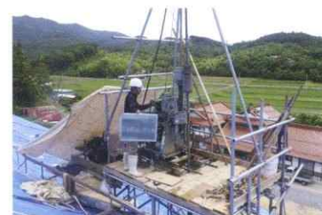
ボーリング調査
