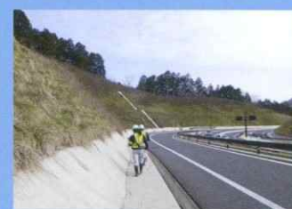
道路防災点検
