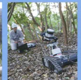
遠隔操作ロボットを活用した調査と三次元デジタル化
