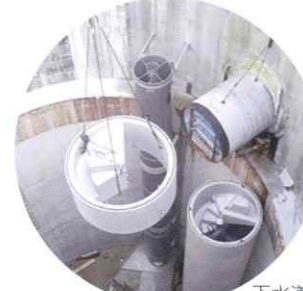
下水道 (落差マンホール)
