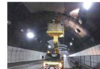
トンネル点検
