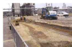
副産物出荷設備の工事
