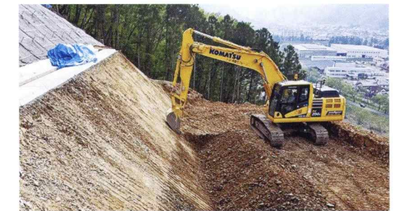
ICT建機による施工
