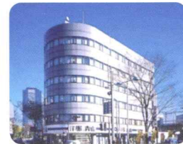
● 第3アルファテックセンター (川崎市中原区)
