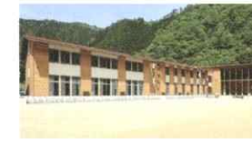
安芸太田町立戸内河内小学校
