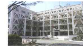
埼玉県本庁舎耐震改修
