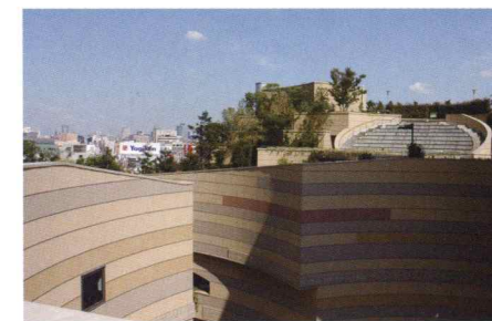
外装施工事例/「ジョリパット」
