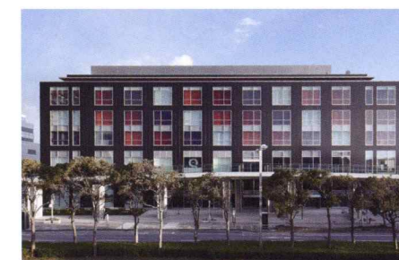
外装施工事例/押出成形セメント板「メース」
