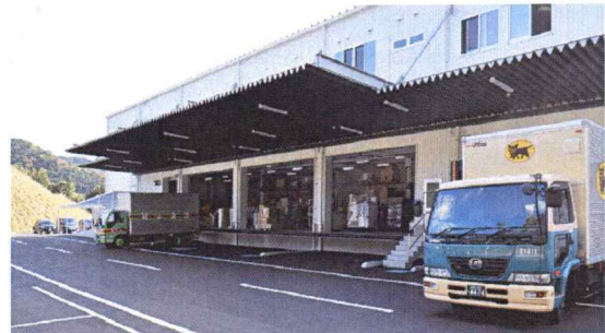
敷地面積3000坪、建物面積1600坪。
