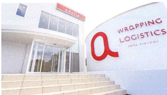
敷地面積3300坪、建物面積1600坪。
